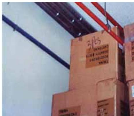
*Canalizaciones sin protección y apilamiento indebido*
