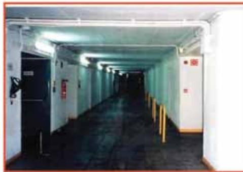
*Zona de separación de vehículos y peatones en un túnel de una instalación industrial*
