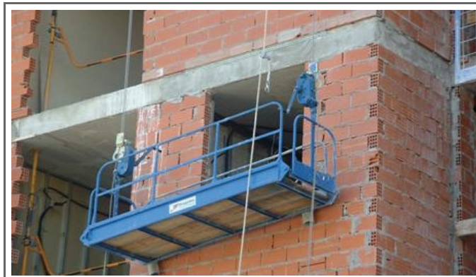
Andamio colgado móvil de un solo módulo
