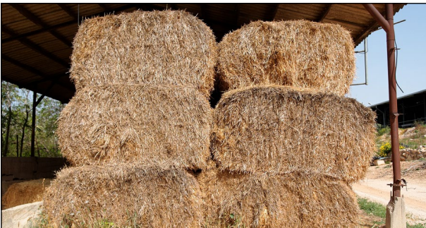
Foto 5. Almacenamiento en edificios. Cobertizo con laterales abiertos.
