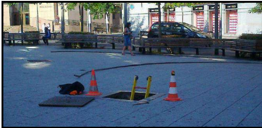
Recinto confinado deficientemente señalizado
