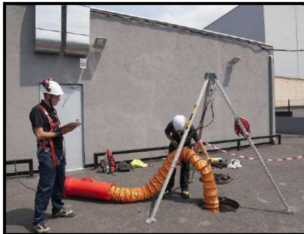
Instalación de un sistema de ventilación
