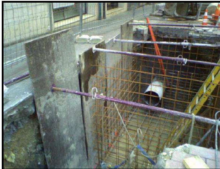
Entibación con planchas de metal
