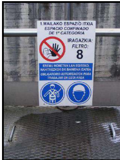
Recinto confinado adecuadamente señalizado
